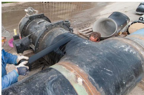
Aanbrengen mechanische beschermlaag
