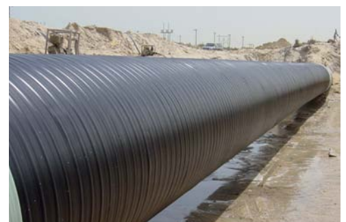
Buisrehabilitatie: voor en na
