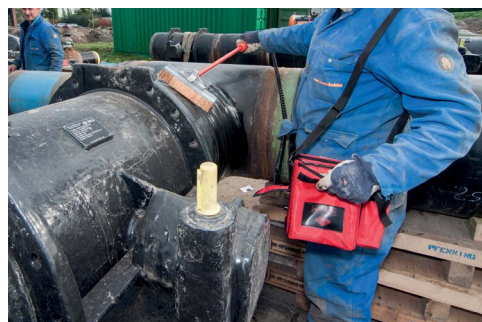
Bekleding testen op o.a. luchtinsluitingen, porositeit, etc. met afvonkapparaat
