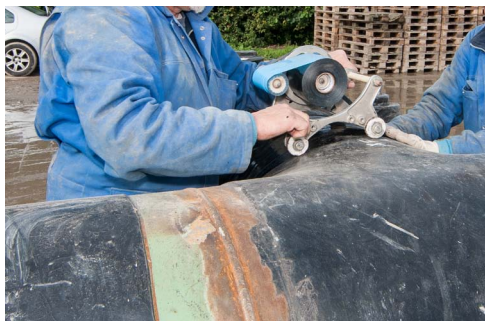
Aanbrengen Polyken wikkelband met wikkelmachine
